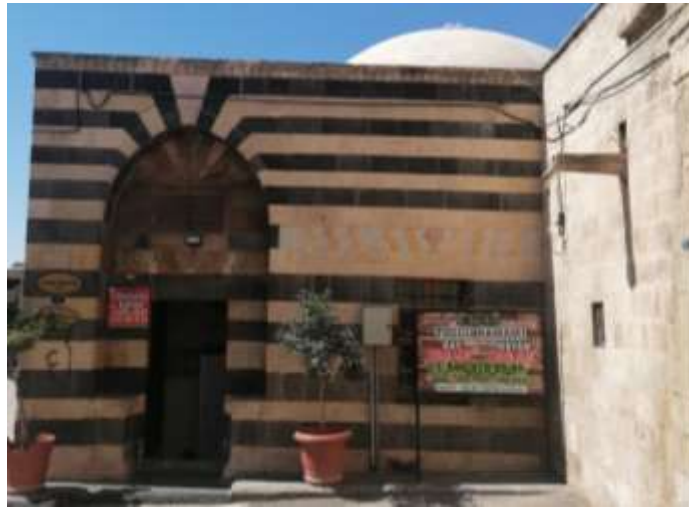
Ek. 13. Tuğlu (Toğlu) Hamamı Giriş Cephesi.
