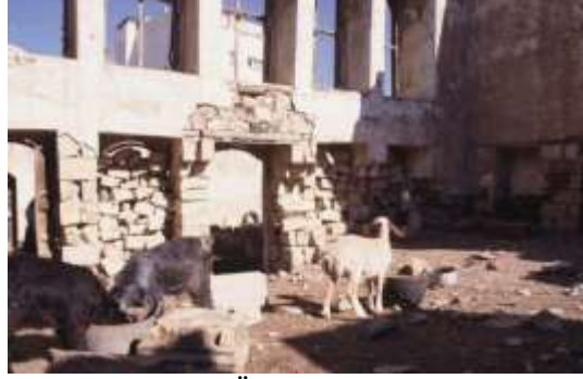
Ek 5. Kilis Sinagogu, Restorasyon Öncesi Doğu Cephesi ( https://www.omnia.ie/ )
