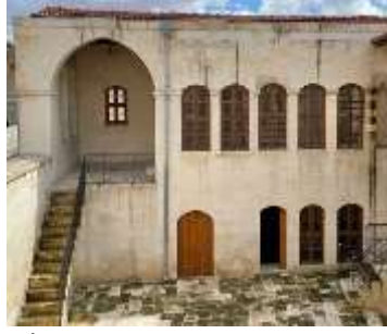
Ek 23. Kilis Sinagogu, Restorasyon Sonrası, Doğu Cephesi
