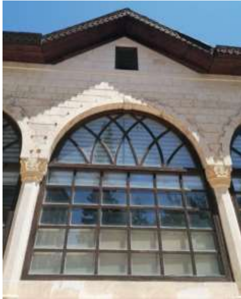
Ek. 50. Çocuk Kütüphanesi'nin Cephesinde Yer Alan Kemelerden Bir Örnek.
