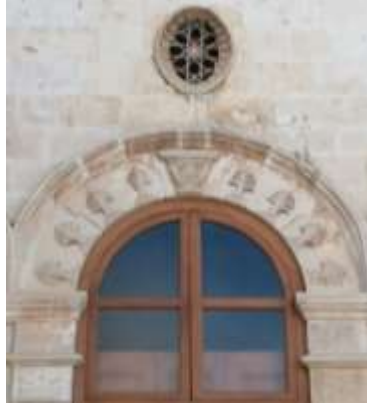
Ek 17. Kilis Sinagogu, Restorasyon Sonrası, Güney Cephedeki Üç Bölmeli Girişten Süsleme Detayı
