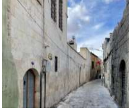
Ek 6. Kilis Sinagogu, Doğu-Batı Aksı ve Kuzey Cephe
