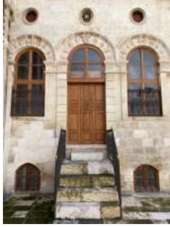
Ek 16. Kilis Sinagogu, Restorasyon Sonrası, Güney Cephedeki Üç Bölmeli Giriş
