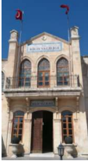
Ek. 47. Valilik Binası (Eski Hükümet Konağı), Giriş Cephesinden Detay.
