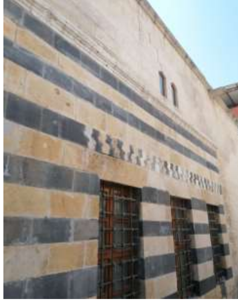
Ek. 10. Paşa Hamamı Batı Cephesi.
