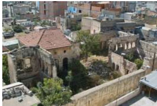
Ek 3. Kilis Sinagogu, Restorasyon Öncesi Genel Görünüm ( https://www.omnia.ie/ )
