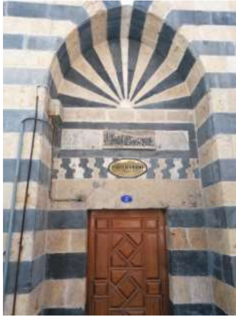
Ek. 8. Paşa Hamamı Giriş Cephesi.
