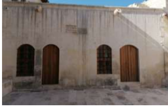
Ek 12. Kilis Sinagogu, Restorasyon Sonrası, Batı Cephesi Genel Görünüm
