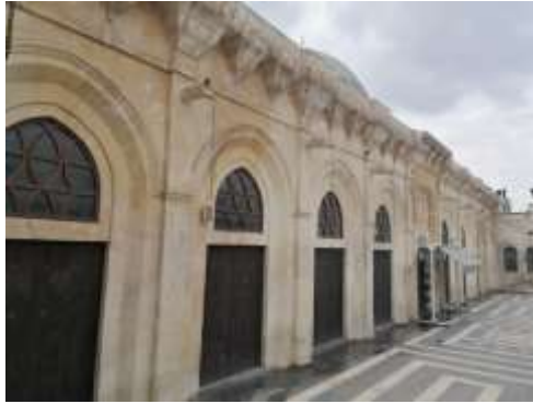
Res. 17. Kilis Ulu Cami, Güney Cephe, Saçak Hizasında Yoğunlaşan Üçgen Konsollar ve Testere Dişleri
