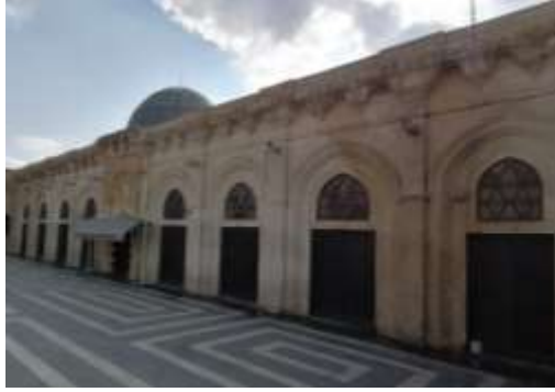
Res. 16. Kilis Ulu Cami, Güney Cephe Genel Görünüm
