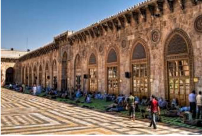
Res. 31. Halep Ulu Cami, Güney Cephesi Genel Görünüm
