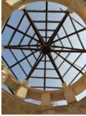
Res. 4. Kilis Ulu Cami, Kuzeydoğu Revak Kısımını Örtten Ahşap Çatmalı Kubbe
